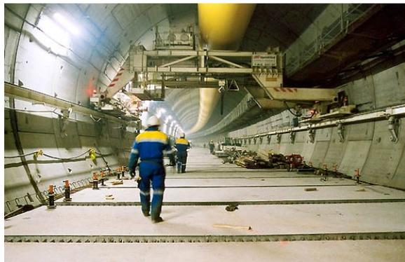
Abbildung 9: SOCATOP West Tunnel VLI, Paris, France: Ausbruchsdurchmesser 11.56 m, einschaliger wasserdichter Tübbingausbau ( $t=42$  cm)
